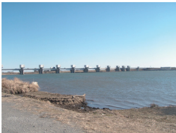
利根大堰:上流から
